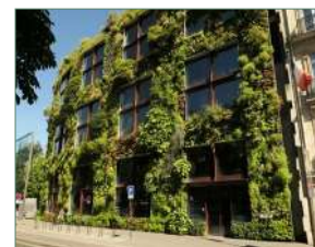
Mur végétalisé, musée du Quai Branly, botaniste Patrick Blanc, architecte Jean Nouvel
